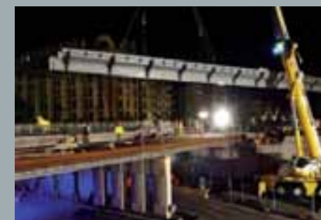
Création de la gare Jean Macé à Lyon
