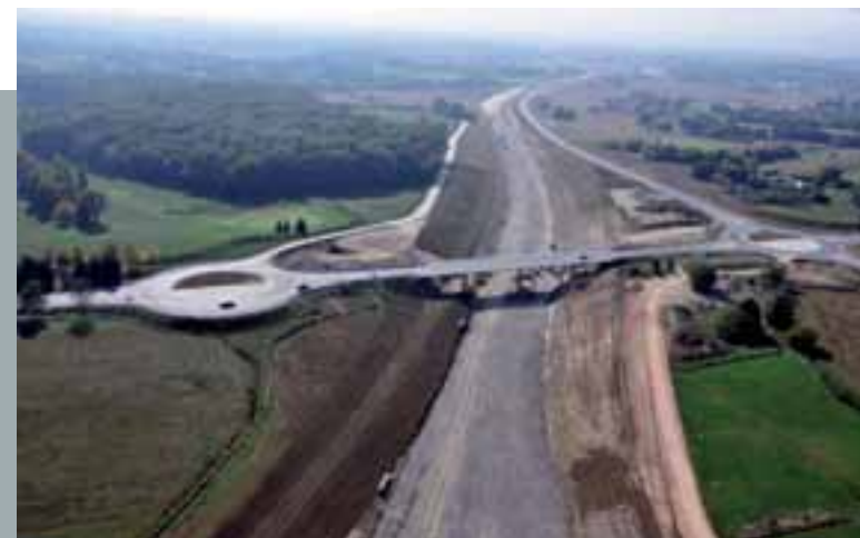
Ouvrage d'art sur l'A 406
