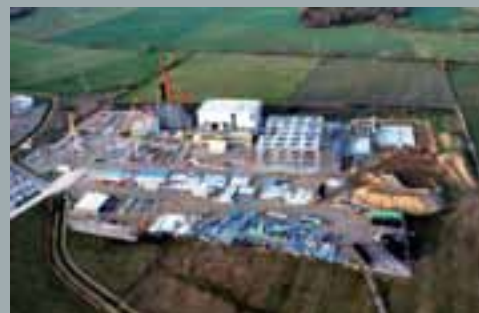
Central électrique de 400 MW du Bayet
