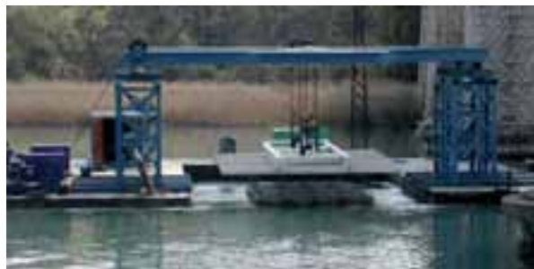
Vernaison (26) : confortement du viaduc SNCF sur l'Isère. Dragages, mise en œuvre de gabions et enrochements
