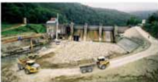
Barrage du Grosbois (25) : renforcement du radier aval
